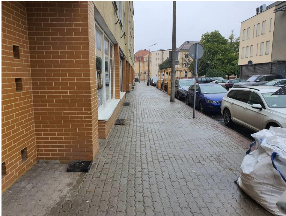
fot. 2 Wizja lokalna w terenie – ul. Zamenhofska – chodnik po stronie zachodniej
