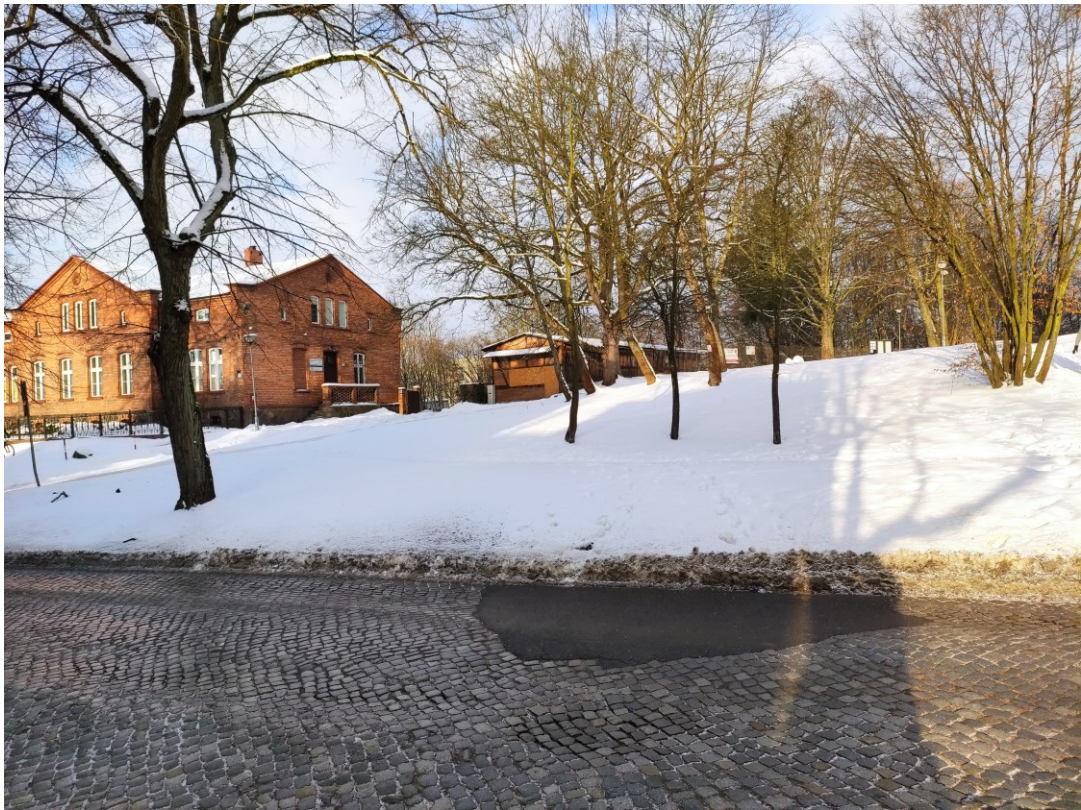
fot. 3 Wizja lokalna w terenie – uszkodzenia nawierzchni – łaty i zapadnięcia
