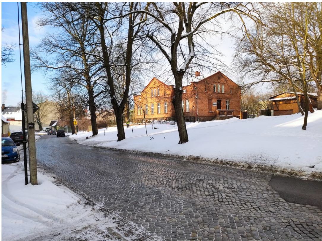
fot. 4 Wizja lokalna w terenie – nierówności nawierzchni
